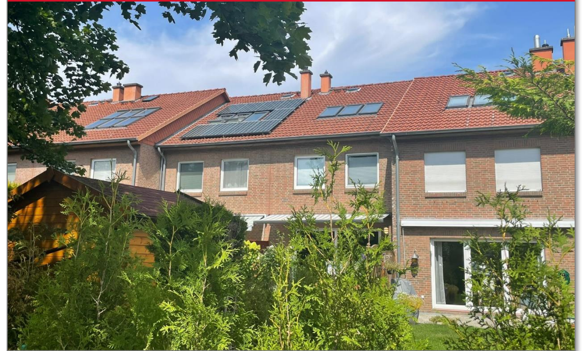
Photovoltaik für das Reihenhaus
